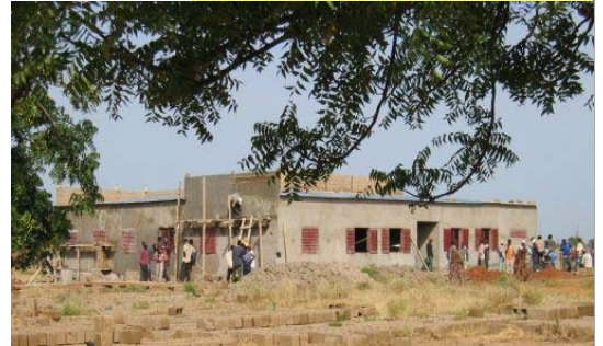
CSCOM de Kolobo en construction (coopération décentralisée Kolobo Gentilly).
